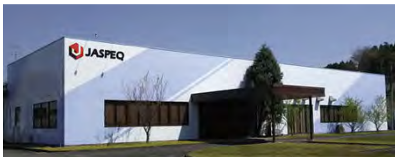
本社(熊本工場)
